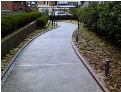
ヒーター敷設箇所
